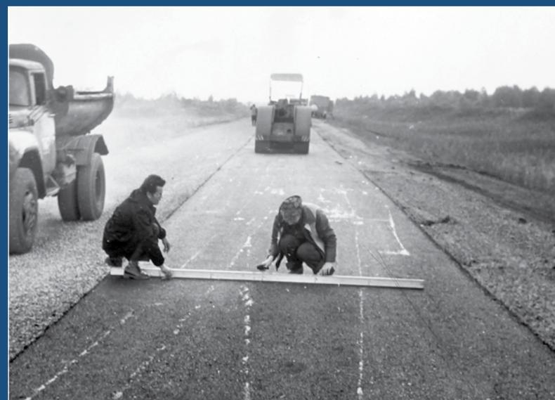
Автомобильная дорога Красноярск – Абакан. Идет реконструкция дорожной одежды. На переднем плане – проверка ровности покрытия. При реконструкции покрытия применяется прогрессивная технология – без закрытия движения по дороге
